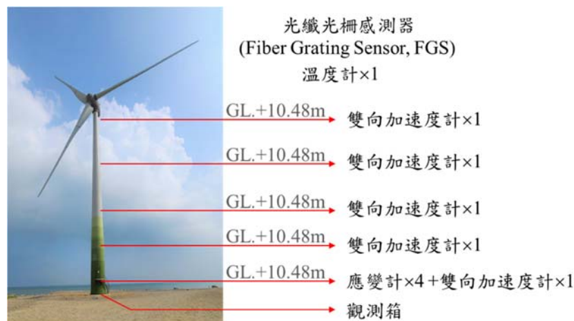
圖一：陸域風力機外觀及儀器配置
